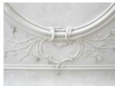
Die freigelegten alten Stuckdecken zieren jetzt die Gruppenräume.
